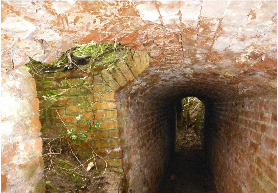
Afbeelding 2.55: in de af te sluiten gangen worden ook de vluchtgaten dichtgelegd (14 februari 2016, Greenspot).
